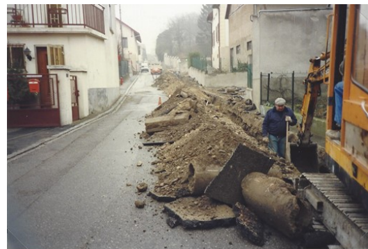
Janvier 1992 : travaux de remise en service de la fontaine rue des Images. On déterre des restes de tuyaux en bois et en céramique qui approvisionnaient les anciennes fontaines.
