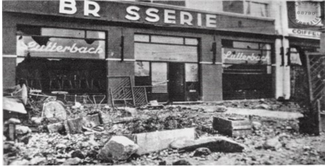
16 juin 1940 - Premiers dégâts de la guerre
